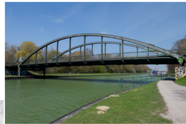
Pleistemühlenweg-Brücke: Die Anliegerbrücke wird voraussichtlich ab Mitte 2017 neu errichtet und an den künftigen DEK-Querschnitt angepasst.
