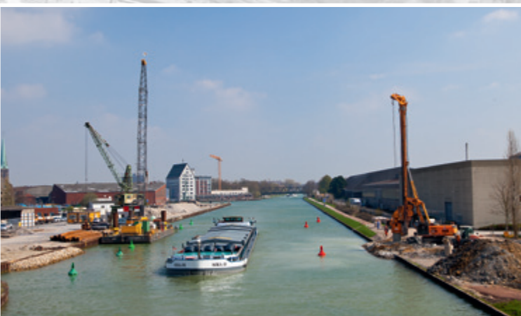
Petershafen-Düker: Der Kanalausbau startete Anfang 2013 mit dem Neubau des Petershafen-Dükers.
