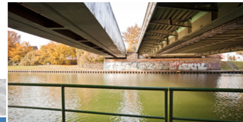
Warendorfer-Straßen-Brücke: Das Kreuzungsbauwerk wird mit der parallel verlaufenden Mauritzer Eisenbahnbrücke als letztes an die neuen Abmessungen angeglichen.
