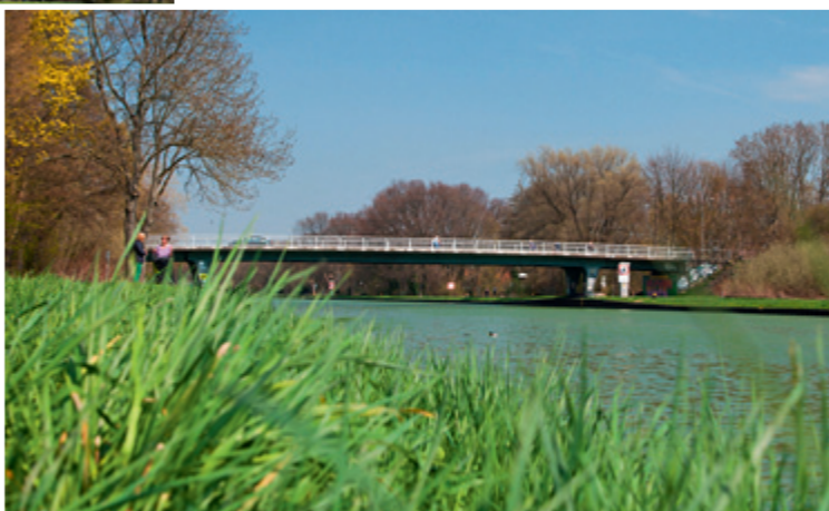
Laerer-Landweg-Brücke: Das Brückenbauwerk wird voraussichtlich ab Mitte 2015 mit der Manfred-von-Richthofen-Straße neu errichtet.
