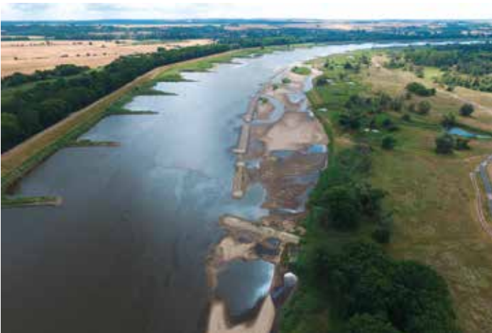
Aufweitungsbereich und Parallelwerk
