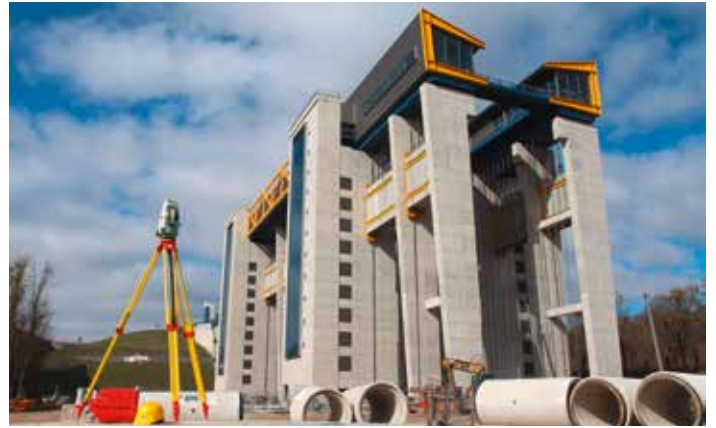
Neubau des neuen Schiffshebwerks Niederfinow
