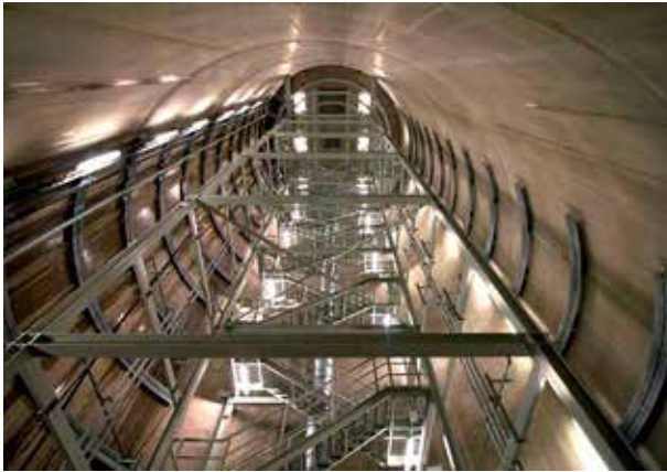
Blick vom Boden des Startschachts auf den Treppenturm
