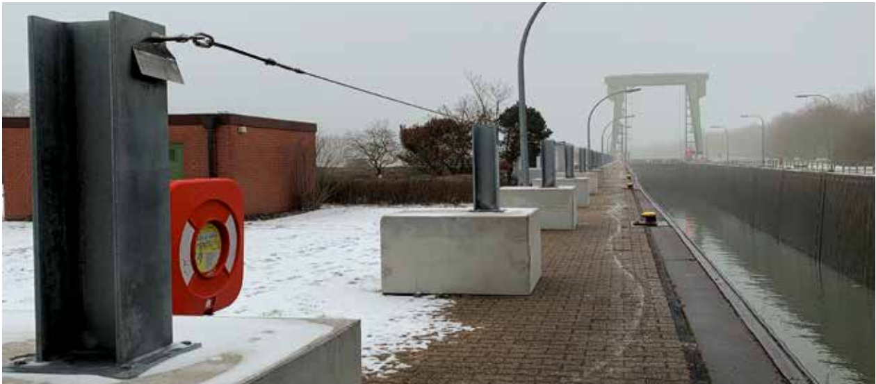
Absturzsicherung über die gesamte Schleusenkaute und Kantenpoller
