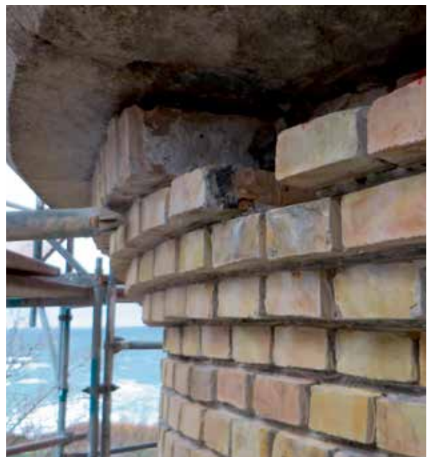
Mauerwerkssanierung Gesims
