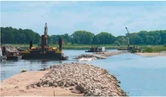
Errichtung des Parallelwerks bei Reitwein an der Oder
