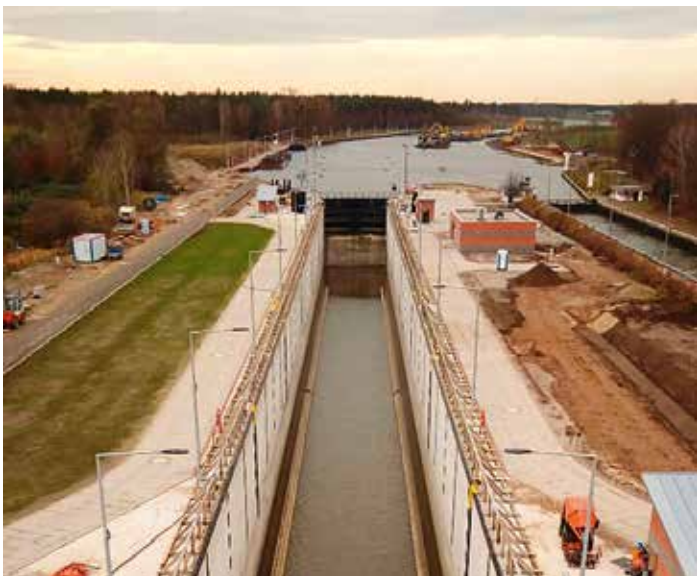
Neue Schleuse Zerben und oberer Vorhafen
