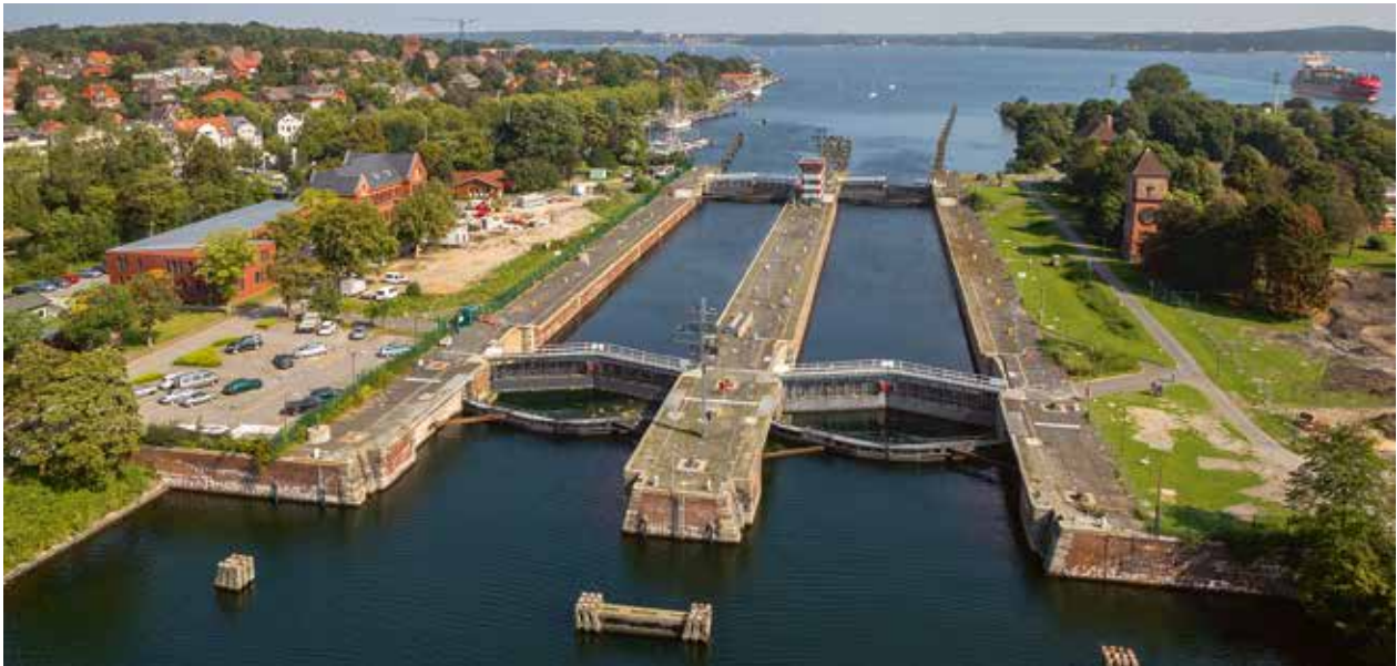
Kleine Schleusenanlage Kiel-Holtenau
