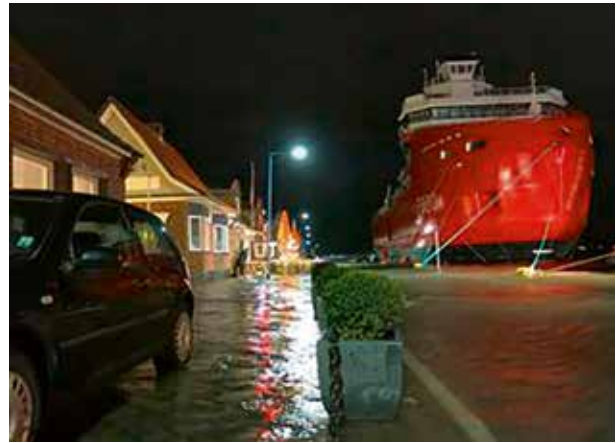
Tiesenkai mit Hochwassersituation (4./5.01.2017)
