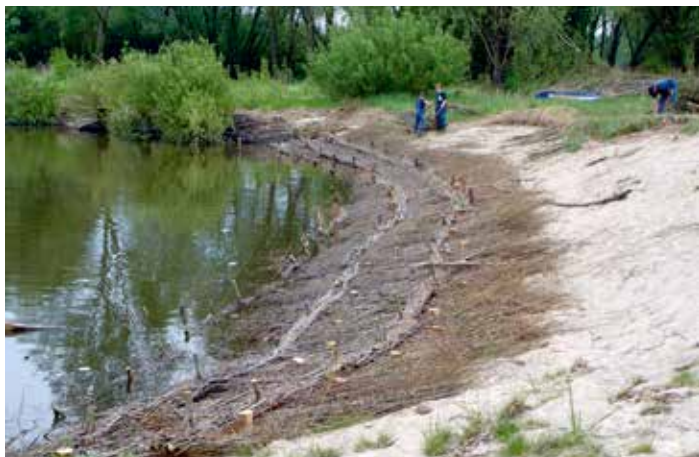
Technisch-biologische Ufersicherung mit Faschinen
