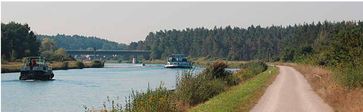
Artenreiche Strukturen an der Wasserstraße
