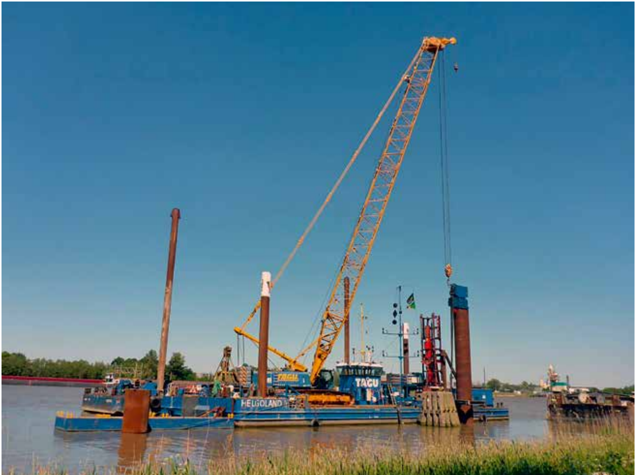
Einbringen eines neuen Stahlmonodalbens; daneben ein altes Holzdalbenbündel. Quelle: ARGE NOK Weichendalben 2017/Möller
