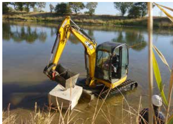
Einbringen des Schleppankers zur Fixierung der Totholzelemente
