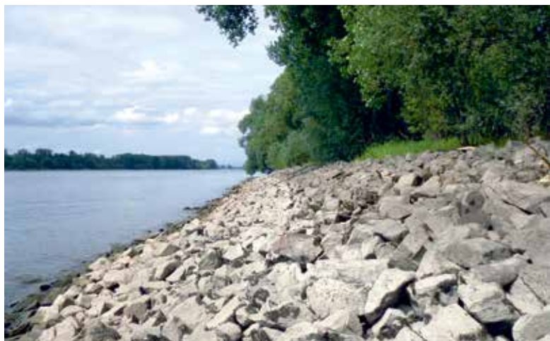
Noch vorhandene Steinschüttung
