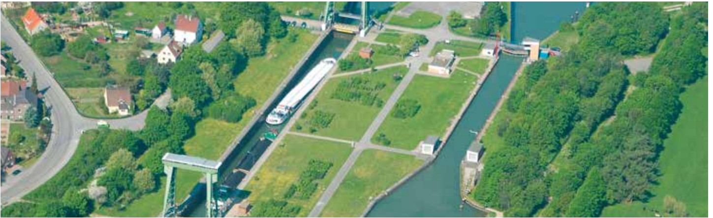
Schleuse Friedrichsfeld am Wesel-Datteln-Kanal
