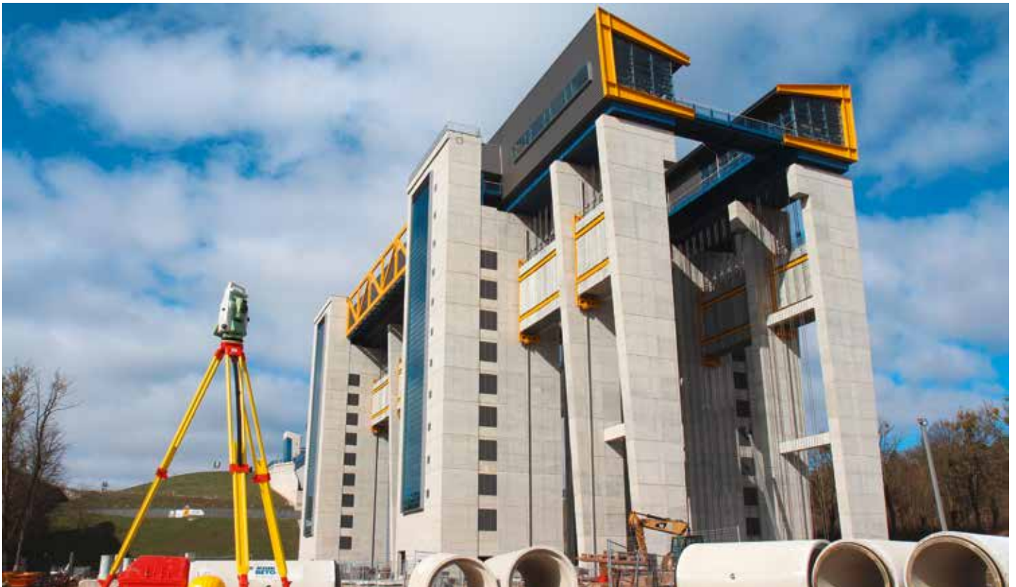
Neues Schiffshebewerk Niederfinow im Bauzustand
