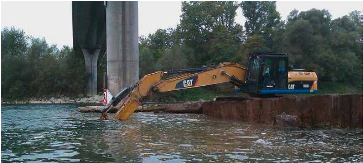
Rückbau der Ersatzübergangsstelle
