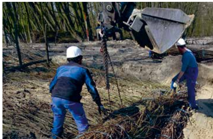
Verlegen der Fußsicherung
