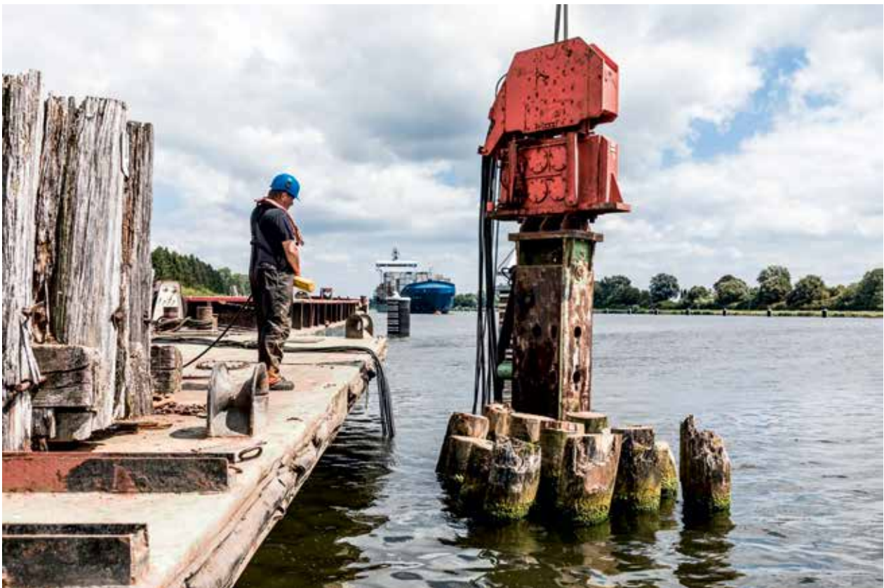
Rückbau alter Holzdalbenbündel; Im Hintergrund ein neuer Stahldalben.
