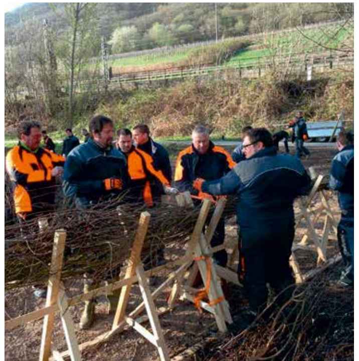
Mitarbeiter beim Bau einer sogenannten „Wippe“ zur Ufersicherung
