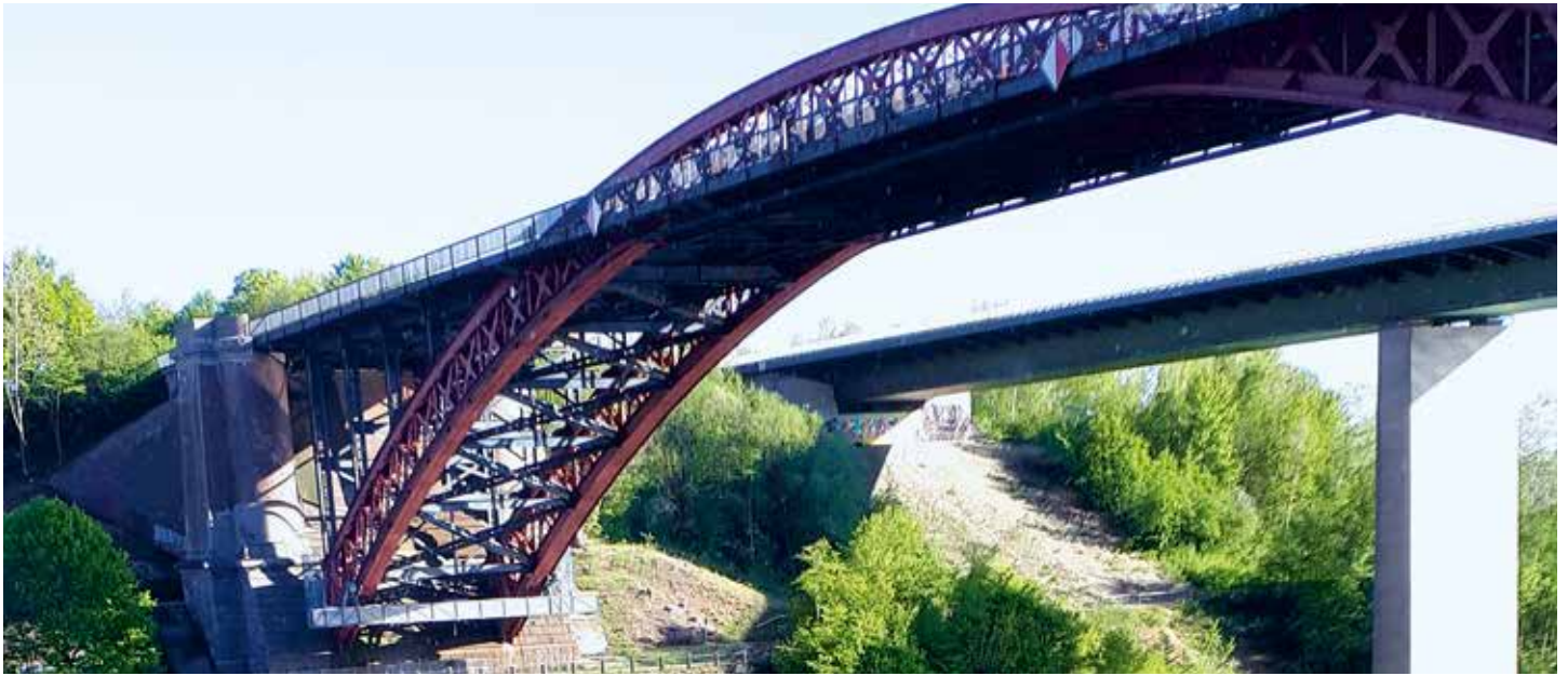
Blick von der Südseite auf den Bogen und das Widerlager
